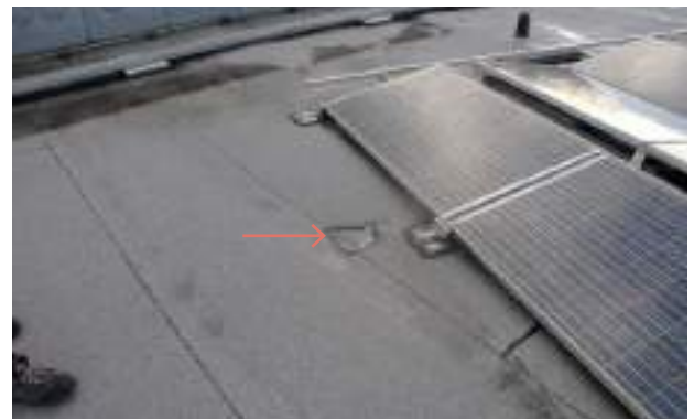
Abbildung 5: Verschiebung der Ausrichtung von flachen PV-Modulrahmen – Pfeil zeigt die ursprüngliche Position (Quelle: Zurich)
